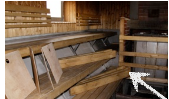
Ison saunan löylyvesikaivon päälle tulevat lankut
